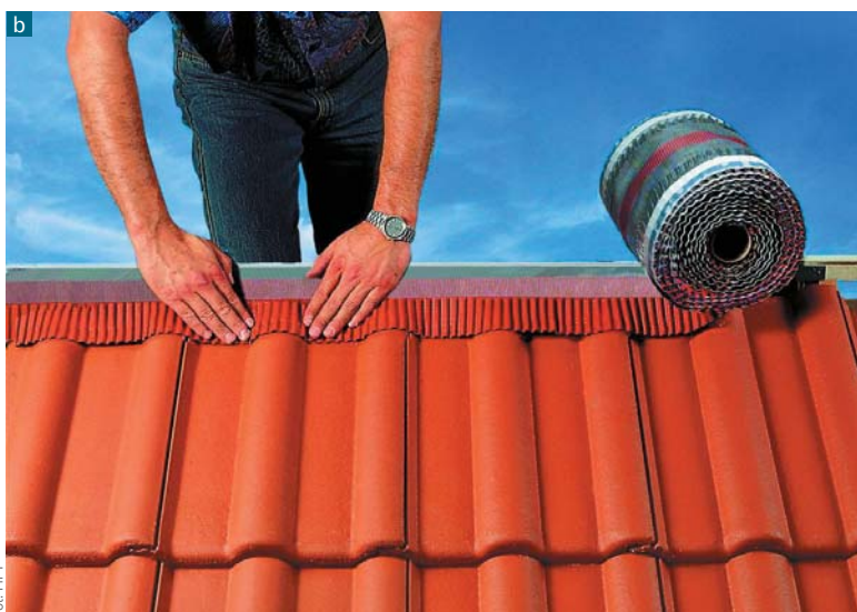
▲ Wentylację pod pokryciem dachowym umożliwiają: a) ruszt z łąt i kontrłąt, b) otwory w kalenicy, c) specjalne dachówki i kominki w miejscach gdzie, utrudniona jest wentylacja
