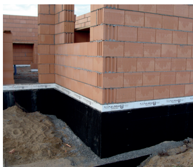
Rys 1. Izolacja cieplna na górnej powierzchni stropu lub płyty przyziemia.
