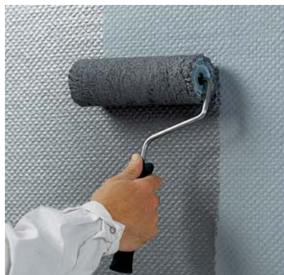
▲ Kolejne etapy wykańczania ścian tapetami z włókna szklanego: przyklejanie tapet (a), kładzenie pierwszej warstwy farby lub gruntowanie (b), kładzenie drugiej warstwy farby (c) oraz efekt końcowy (d)
