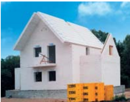
Do wyrobu elementów z betonu komórkowego służą te same surowce, co do produkcji silikatów, jednak odmienna technologia nadaje mu inne właściwości (fot. Ytong)
