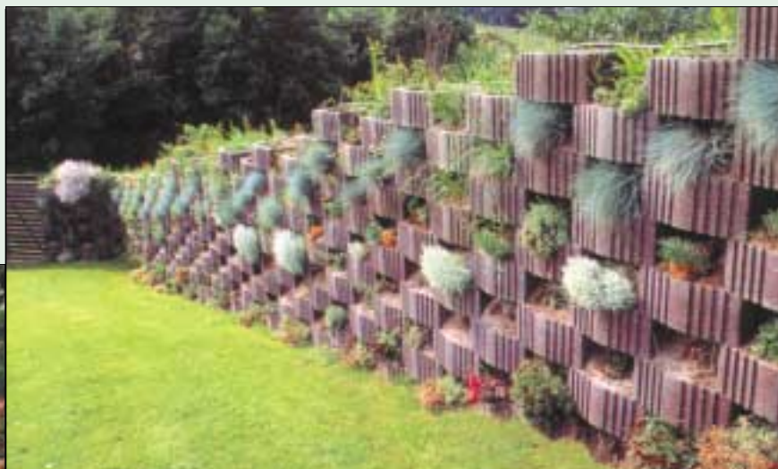
10 Mur z gazonów wyposażonych w system nawadniania (fot. Poz – Bruk)
