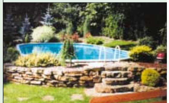
2 Basen okolony skarżą podtrzymywaną przez suchy mur z płyt kamiennych (fot. Juex Garden)
