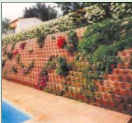
9 Mur z gazonów nachylony w kierunku skarpy (fot. Libet)
