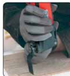
cięcie głębokie w panelach i drewnie
