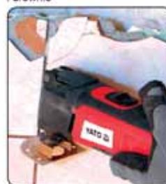
przecinanie glazury, wymiana pękniętych płytek i silikonów
