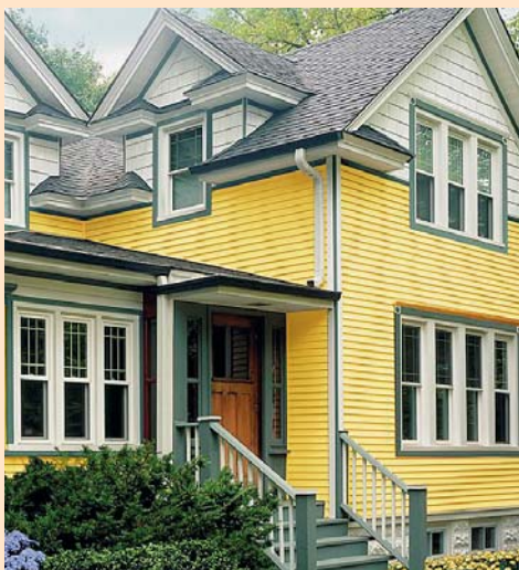
▲ Siding winylowy produkowany jest w wielu kolorach i fakturach imitujących rysunek słoików drewna. Panele przykręca się do elementów rusztu nośnego, a w razie uszkodzenia wymienia się cały panel
