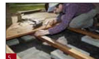
5 Przygotowanie konstrukcji nośnej.
