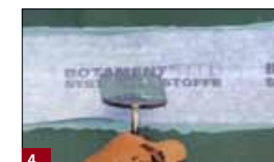
4 Wtłoczenie systemowej taśmy uszczelniającej w pierwszą warstwę izolacji.
