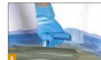
6 Nałożenie w dwóch warstwach izolacji BOTAMENT® MD 2 THE BLUE 1 .
