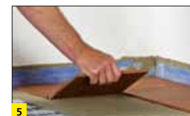
5 Klejenie płytek ceramicznych metodą kombinowaną na zaprawie klejowej MULTISTONE®, MULTILIGHT, BOTAMENT® 29/29HP.
