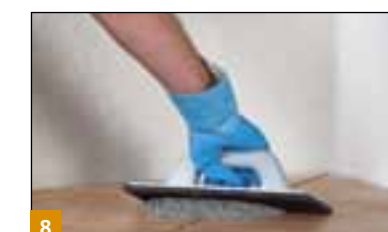
8 Spoinowanie okładziny przy zastosowaniu MULTIFUGE® Base.
