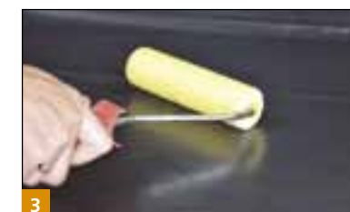
3 Wykonanie hydroizolacji z bitumicznej izolacji samoprzylepnej BOTAMENT® KSK.
