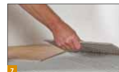
7 Klejenie płytek ceramicznych na zaprawie klejowej np. MULTISTONE®, MULTILIGHT, BOTAMENT® 29/29HP.
