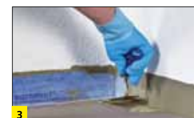
3 Wklejanie taśmy uszczelniającej BOTAMENT® SB 78 w narożnikach wewnętrznych, w warstwę zaprawy klejowej BOTAMENT® M 21 lub BOTAMENT® M 21 HP Speed.
