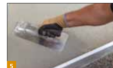
5 Wykonanie warstwy jastrychu z BOTAMENT® M 54 FM.
