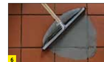
6 Spoinowanie okładziny przy zastosowaniu MULTIFUGE® Base.
