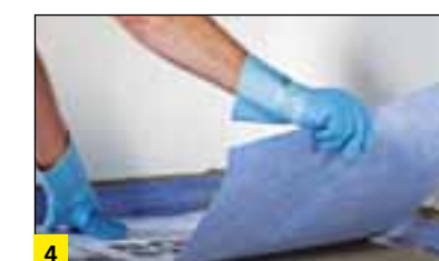
4 Klejenie maty hydroizolacyjnej 2w1 BOTAMENT® AE przy użyciu elastycznej zaprawy klejowej BOTAMENT® M 21 lub szybkowiążącej zaprawy klejowej BOTAMENT® M 21 HP Speed, z zachowaniem 5 cm zakładu.
