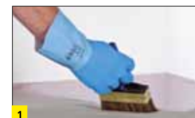
1 Gruntowanie podłoża przy zastosowaniu BOTAMENT® D 11.
