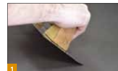
1 Nakładanie grubowarstwowej powłoki bitumicznej BOTAMENT® BM 92 Schnell/Winter w dwóch warstwach.
