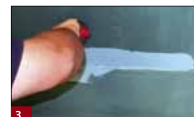
3 Aplikacja BOTAMENT® RD 2 THE GREEN 1 w narożnikach wewnętrznych.
