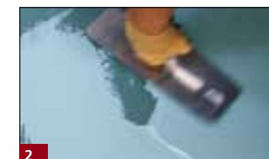
2 Naniesienie powłoki izolacyjnej w dwóch cyklach roboczych.
