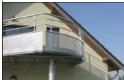
8 Balustrada z elementów aluminiowych (fot. OKF)
