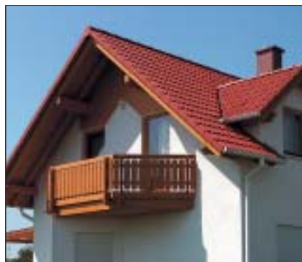
7 Balkon drewniany w budynku szkieletowym (fot. Domikon)
