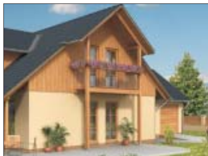
6 Balkon drewniany oparty na słupach może być elementem zarówno domu o konstrukcji szkieletowej, jak i budynku murowanego (fot. HAAS)
