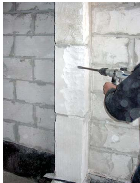
▲ Dla ekipy murującej ściany wymiary zawarte w projekcie były zupełnie nieistotnym drobiazgiem, na który nie należy zwracać uwagi
