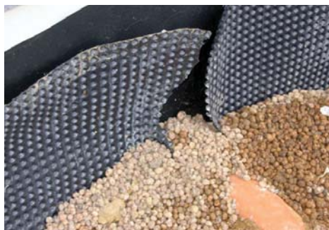
▲ Przekładana folia została w wielu miejscach porozrywana, keramzyt zabrudzono gliną... A gdybym tej ekipie nie pomógł, to nie wiem, czy w ogóle zdołaliby skończyć robotę – wspomina Ryszard
