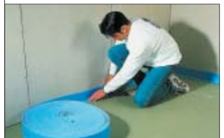
5 Paski dylatacyjne zapobiegają pękaniu betonowego podkładu (fot. Rigips)
