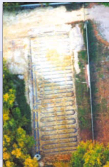
1 Kolektor ziemny poziomy – widok z lotu ptaka (fot. Archiwum Polska Ekologia)
