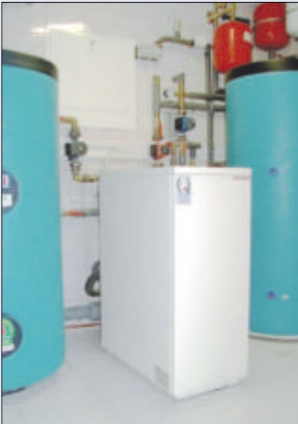
6 Pomieszczenie techniczne z gruntową pompą ciepła, zbiornikiem buforowym c.o. i solarnym zbiornikiem c.w.u. (fot. Archiwum Polska Ekologia)
