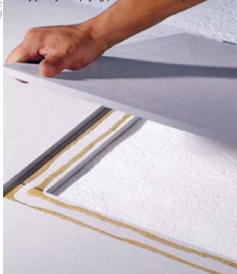
Suchy jastrych z płyt gipsowo-kartonowych
