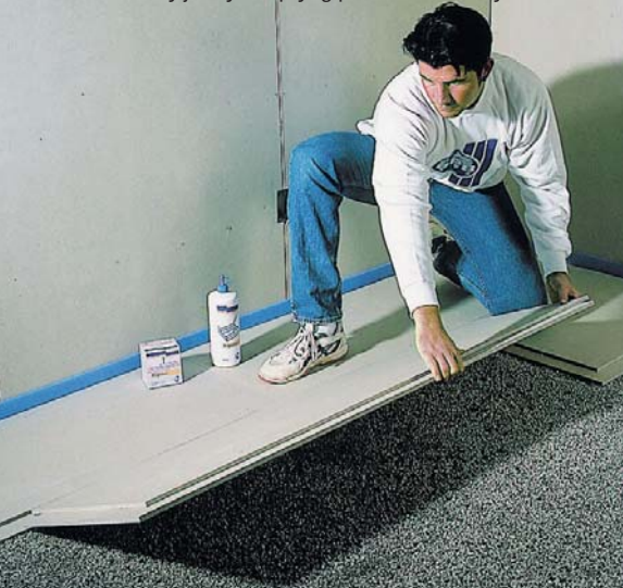
Suchy jastrych z płyt gipsowo-włóknowych
