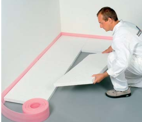
Dylatacja brzegowa. Wykonuje się ją ze specjalnej taśmy dylatacyjnej lub samodzielnie np. z cienkich pasków styropianu
