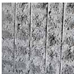
Balustrada po przygotowaniu podłoża
