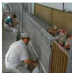
Reprofilacja a następnie szpachlowanie zaprawą drobnoziarnistą
