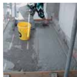
Nanoszenie mostka szcpeznego po zwilzeniu wodą
