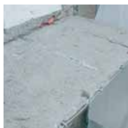
Płyta balkonowa przed naprawą
