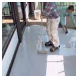
Odpowietrzenie wałkiem kolczastym
