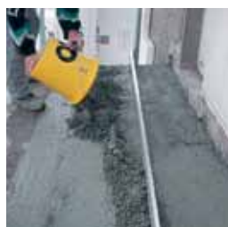
Nanoszenie jastrychu PCC- Jastrych na świeży mostek szczerwny (mokre na mokre)
