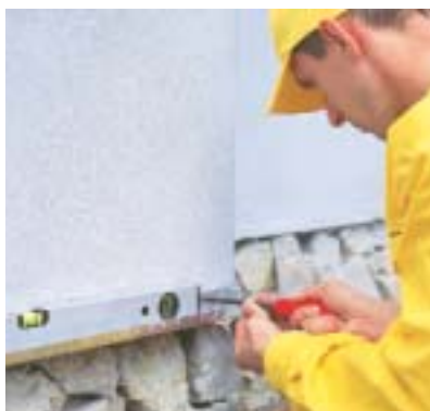
Styropian to materiał wyjątkowo łatwy w obróbce; ocieplając nim elewację trzeba jednak bardzo starannie zamontować listwy startowe (fot. Henkel)
