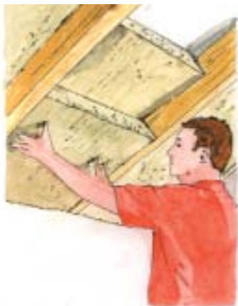
Dwie warstwy płyt wełny mineralnej układamy „na mijankę”
