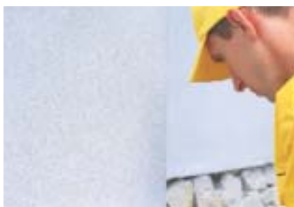
Płyty styropianu klei się do elewacji na zaprawę (fot. Henkel)
