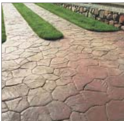
5 Nawierzchnie monolityczne wylewa się z betonu, w którym można odciskać różne wzory (fot. Bautech)
