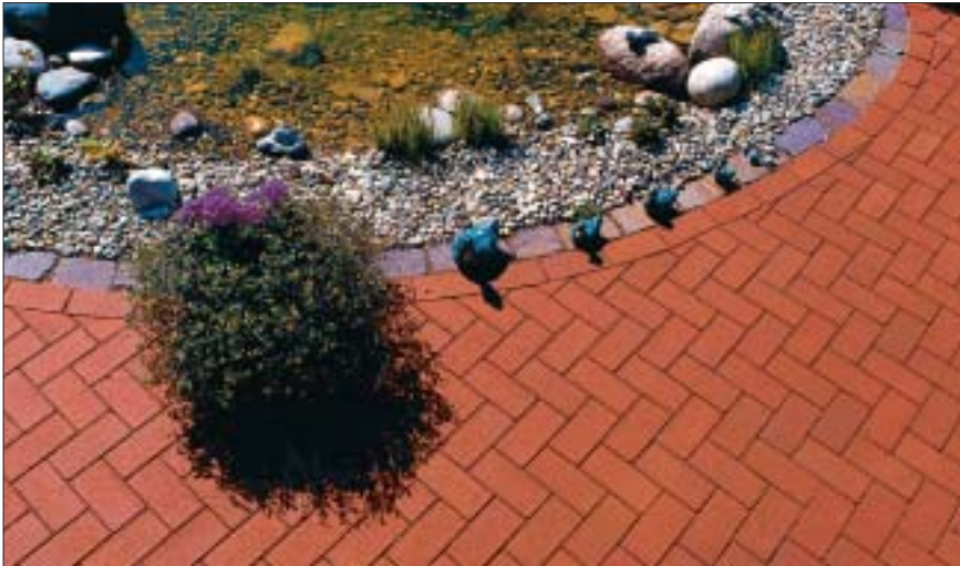
7 Nawierzchnie klinkierowe najczęściej układa się z cegiel na płask (fot. CRH Klinkier)
