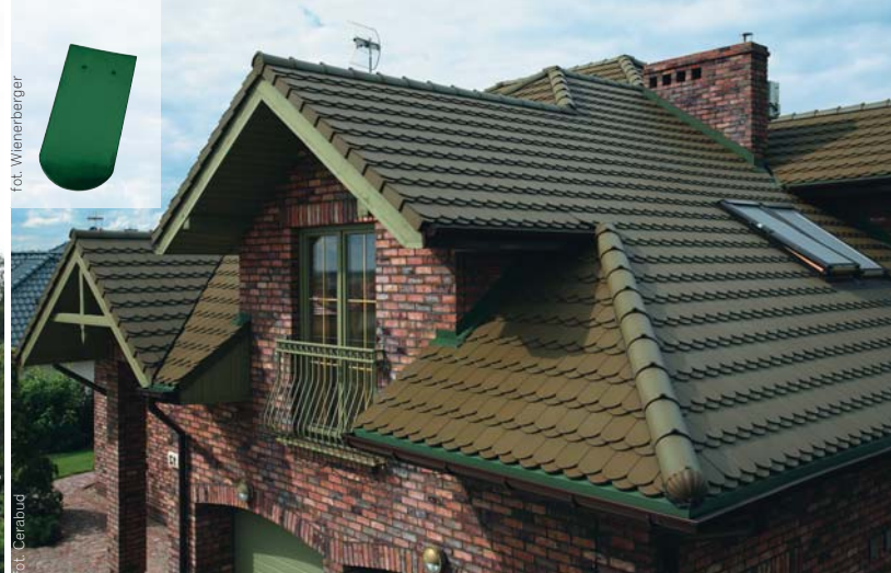
▲ Dachówka karpówka układana w koronkę. Szczególnie atrakcyjnie wygląda na połaciach o dużej powierzchni
