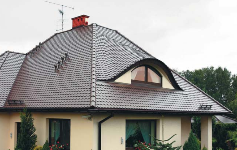
▲ Dach kryty dachówką karpówką w tzw. łuskę. To jeden z niewielu rodzajów dachówek, które nadają się do krycia powierzchni krzywoliniowych
