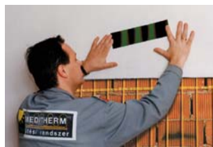
Oznaczenie rurek pod tynkiem
