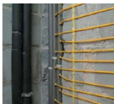
Układanie rurek poziomo
