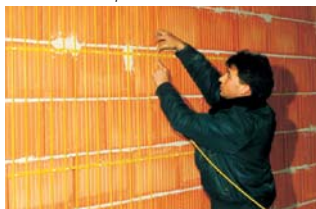
Układanie rurek pionowo
