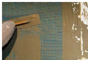
Naciąganie gładzi tynkowej
