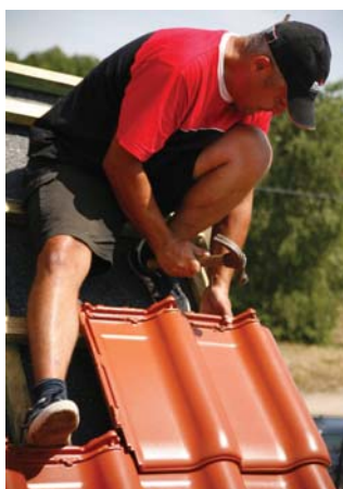
Dachówki brzegowe mocuje się bezpośrednio do łąt
