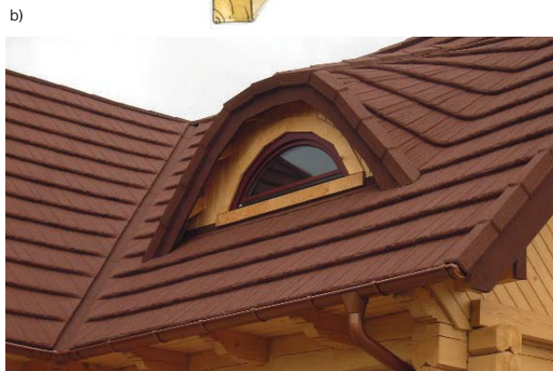
Kosze wykonuje się z blachy (najczęściej powlekanej) (a) lub wykorzystuje się gotowe elementy (b)
