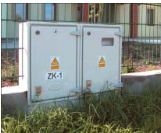
3 Skrzynka elektryczna ustawiana przy ogrodzeniu (fot. archiwum BD)
