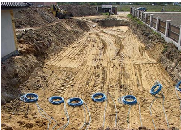
6 Układanie pętli kolektora płaskiego
