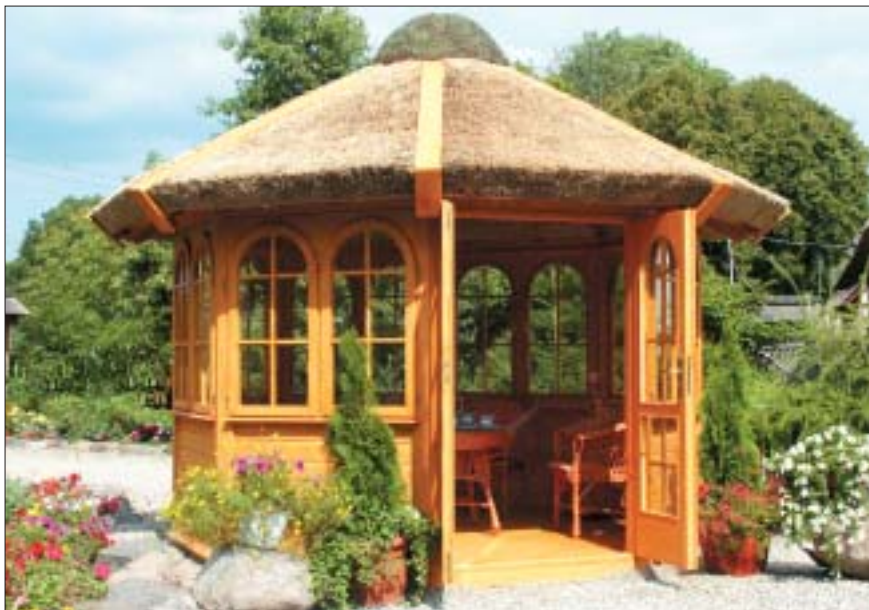
1 W tej altanie można się schronić nawet w deszczowy dzień (fot. Dach Reed)
