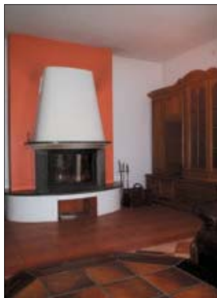
■ Kominek nie zabiera tlenu z salonu, ponieważ ma zapewniony dopływ powietrza z zewnątrz ■
