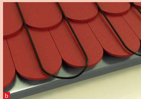
▲ Kable grzewcze zabezpieczające przed zamarzaniem wody w rynnach montuje się (a) w rynnach lub (b) na skraju połaci dachu
