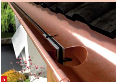
▲ Kable grzewcze zabezpieczające przed zamarzaniem wody w rynnach montuje się (a) w rynnach lub (b) na skraju połaci dachu
