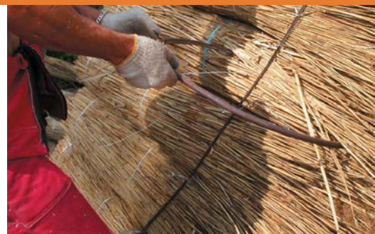
5 Układanie trzciny i mocowanie wiązek (fot. Dach Reed)
