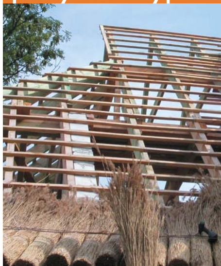
5 Układanie trzciny i mocowanie wiązek (fot. Dach Reed)
