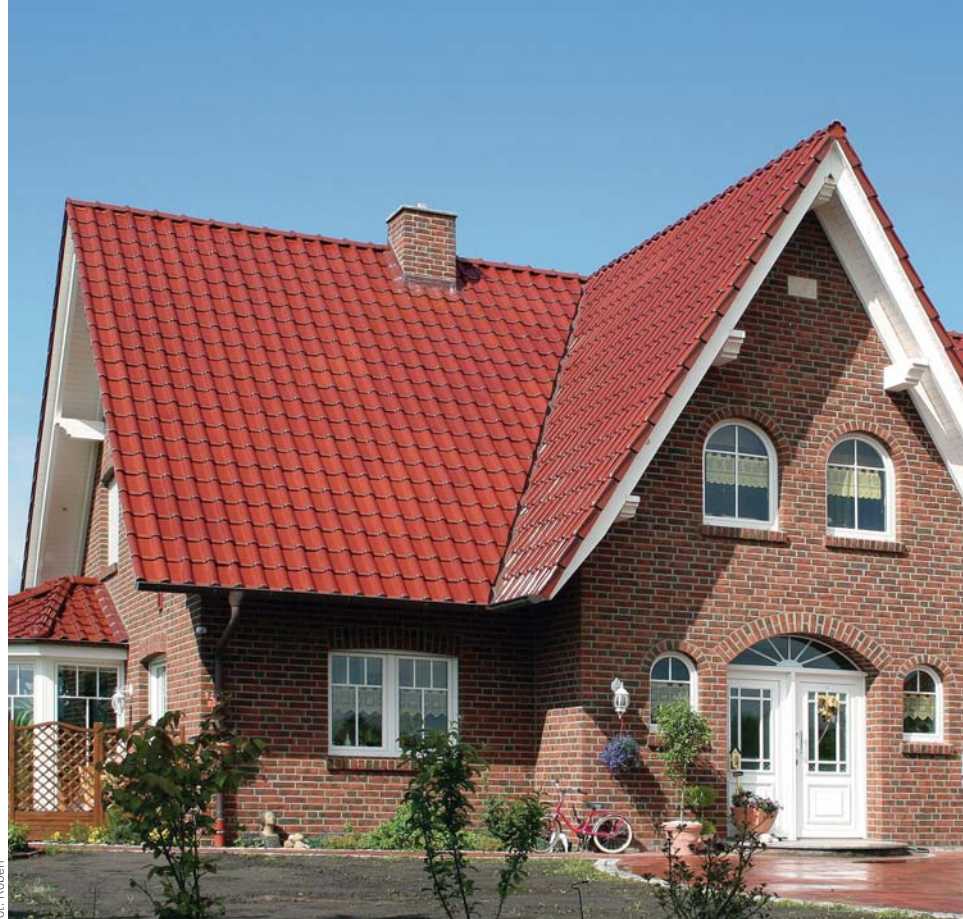
▲ Wystająca z dachu część komina została zabudowana tym samym materiałem co elewacja
