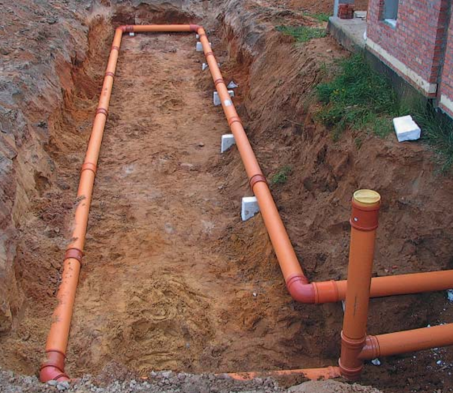
▲ Wymiennik gruntowy do odzysku ciepła nie zużywa energii
