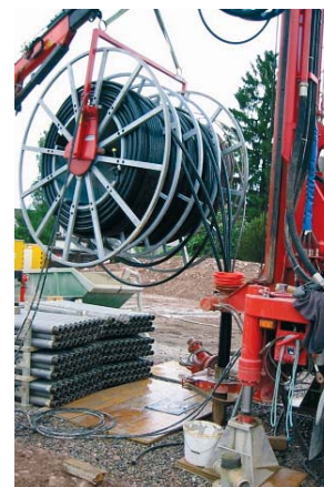
Wkładanie sondy „podwójnej U”
