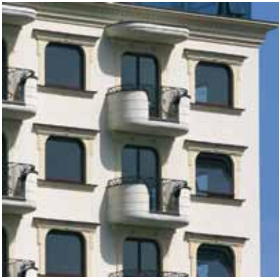
Profile StoDeco na elewacji ocieplonej systemami StoTherm Vario i StoTherm Mineral (Belvedere Residence, Warszawa)
