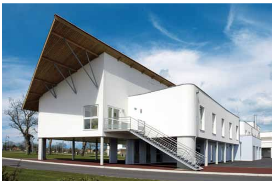
Dobrze wykonane gruntowanie reguluje nasiąkliwość elewacji, dzięki czemu doskonale przygotowuje ją do wykonania powłoki końcowej. ( Hospital Intercommunal du Pays de Retz, Francja )
