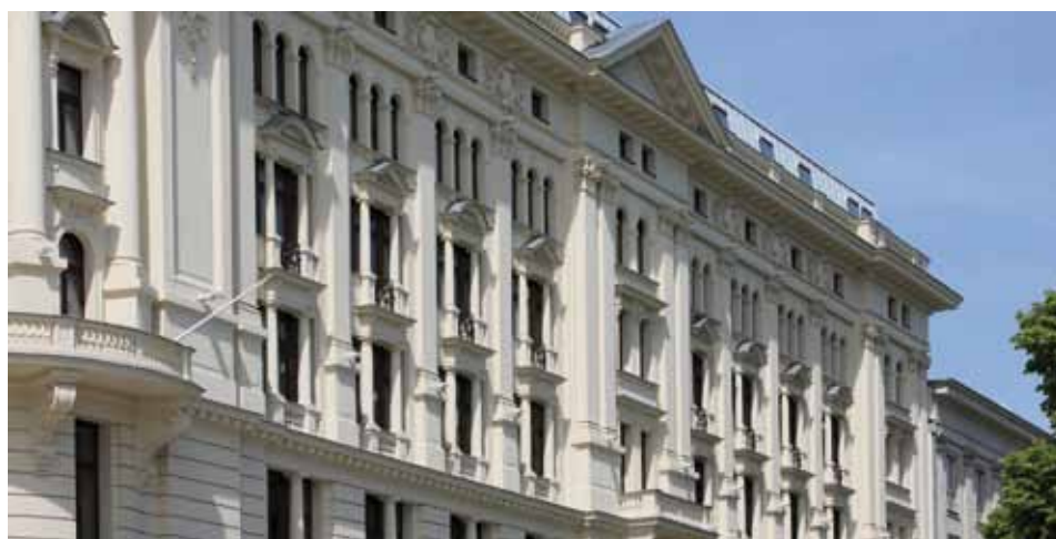
Obróbka wstępna z zastosowaniem preparatu Sto-HydroGrund zmniejsza nasiąkliwość podłoża i zapewnia elewacji wytrzymałe i stabilne podłożo. ( Hotel Bristol, Warszawa )
