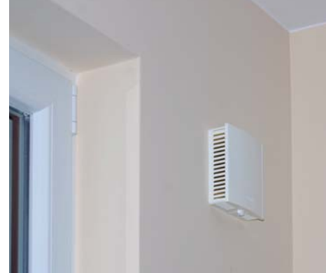
▲ Moduł wentylacyjny tworzy w budynku podciśnienie, a świeże powietrze jest zasysane bezpośrednio z zewnątrz przez specjalne otwory rozmieszczone w ścianach domu
