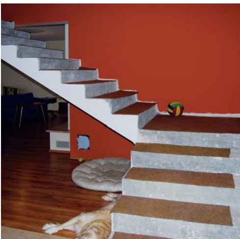
▲ Schody znajdują się jeszcze w stanie surowym. Brak im barierek i dębowego wykończenia stopni. Początek jest już jednak zrobiony, gdyż barierki pojawiły się na piętrze
