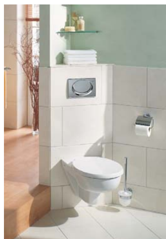
4 Ukrycie rur w ścianie instalacyjnej pozwala elegancko wykończyć łazienkę (fot. Geberit) ▲
