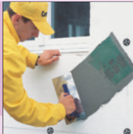
10 Tynki podkładowe i dekoracyjne tynki cienkowarstwowe stanowią nieodłączny składnik systemów ociepleń metodą lekką mokrą (fot. Henkel)
