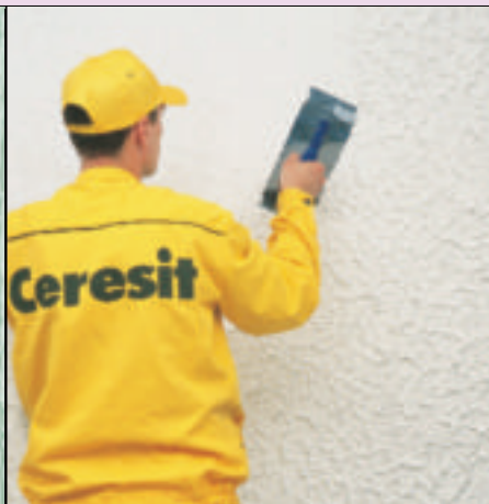
6 Tynki strukturalne pozwalają na uzyskanie wielu różnych faktur (fot. Henkel)
