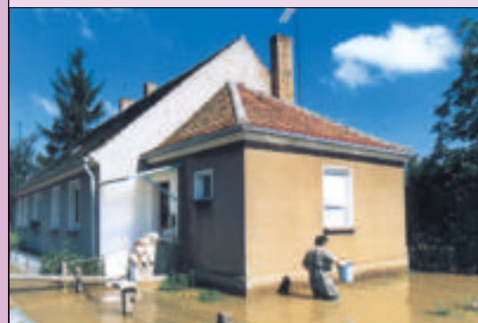
8 Tynki renowacyjne pomagają osuszyć zawilgocone ściany (fot. Baumit)
