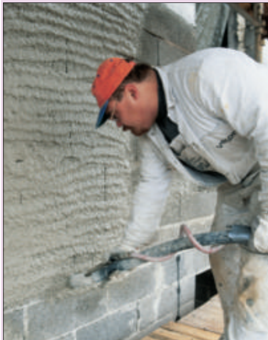
9 Tynki ciepłochronne poprawiają izolacyjność termiczną ścian (fot. Optiroc)
