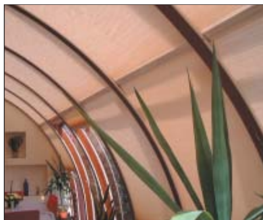
6 Osłony przeskleń łukowych poruszają się w specjalnych prowadnicach (fot. Gracja)
