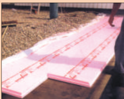
13 Do ocieplania dachu odwróconego najczęściej stosuje się płyty styropianowe (fot. Austrotherm)
