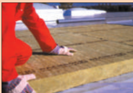
12 Układanie płyt z wełny mineralnej na dachu płaskim (fot. Rockwool)
