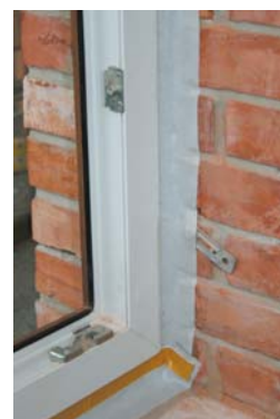
Okno uszczelnione taśmą paroszczelną – strona wewnętrzna
