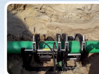
Zgrzewanie doczołowe
