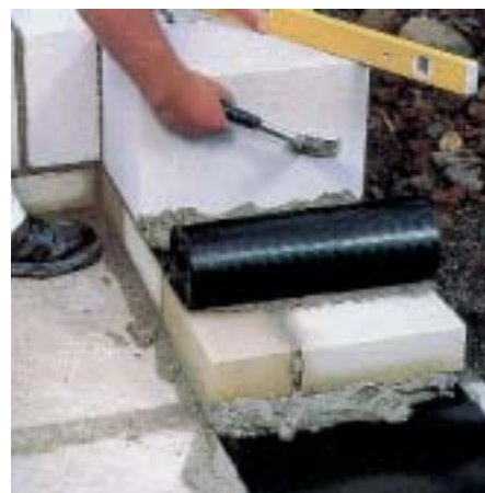
Izolacja pozioma muru (fot. Dorken Delta Folie)
