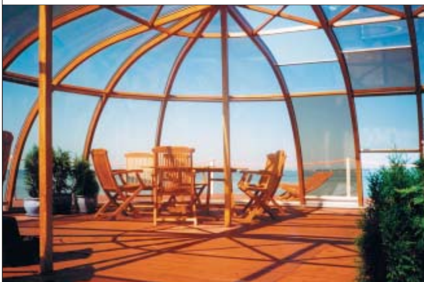
5 Konstrukcja ogrodu musi oprzeć się naporowi wiatru i śniegu; z drewna klejonego warstwowo robi się także profile łukowe (fot. Gracja)
