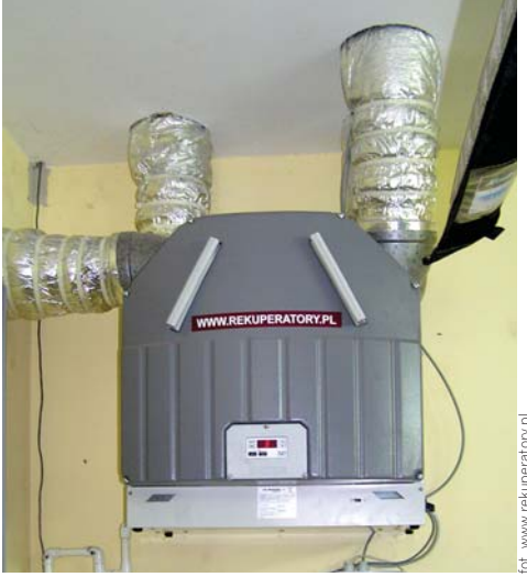
▲ Centrala wentylacyjna z rekuperatorem jest niezbędnym urządzeniem w domu energooszczędnym
