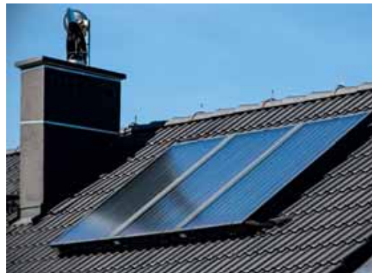
▲ Instalacja solarna zawsze pracuje w układzie biwalentnym, czyli w parze z drugim źródłem ciepła. HEWALEX
