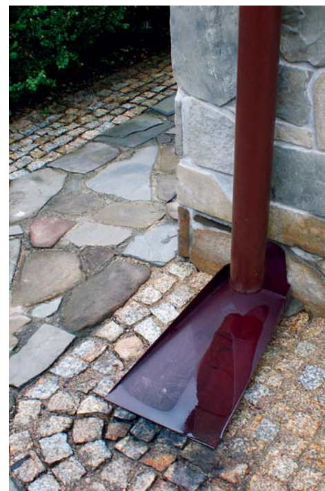
▲ Prosty sposób odprowadzenia wody opadowej jak najdalej od ścian domu
