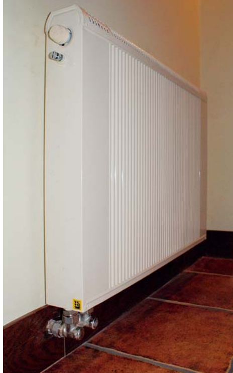
▲ W całym domu wykorzystane są grzejniki firmy Regulus System z dolnym podłączeniem
