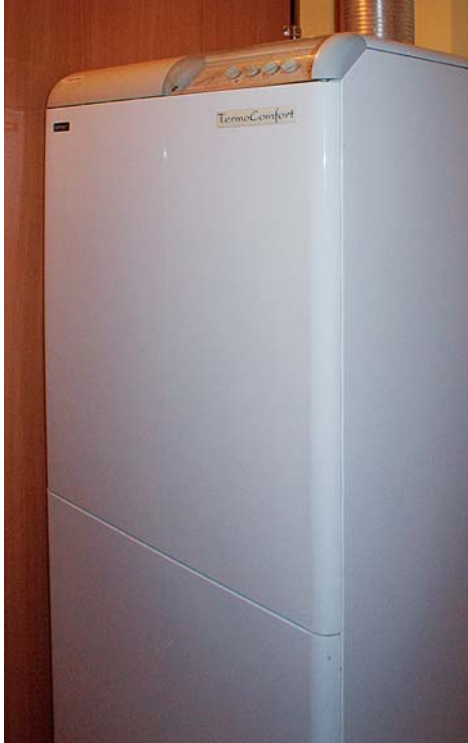
▲ Dwufunkcyjny kocioł gazowy centralnego ogrzewania ustawiony jest w jednym z pomieszczeń przyziemia
