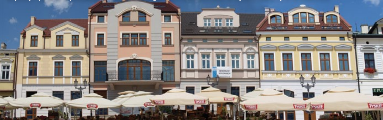
Gzymsy i profile wykonane z betonu lekkiego na 4 kamienicach w Rynku Głównym Rzeszowa
