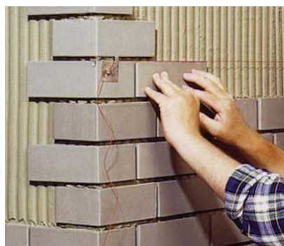
4 Zagięte pod kątem prostym płytki ułatwiają wykonanie naroży (fot. Röben) ▼
