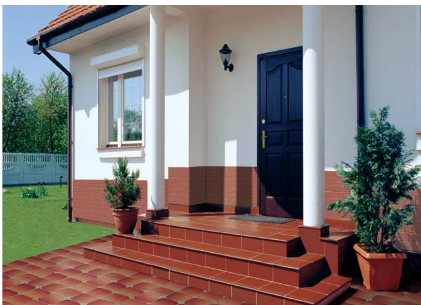
3 Klinkier może podkreślić urok tynku... a może odwrotnie? (fot. Cerrad) ►
