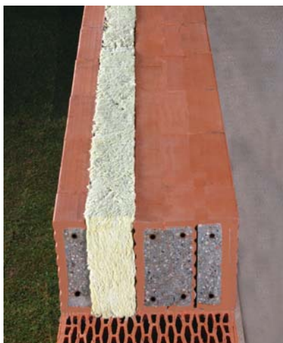
2 W ścianie trójwarstwowej elewacja powstaje podczas jej wznoszenia (fot. Wienerberger) ▲
