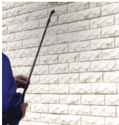
6 Elewacja z silikatów wymaga po ułożeniu zaimpregnowania (fot. Silka) ▲
