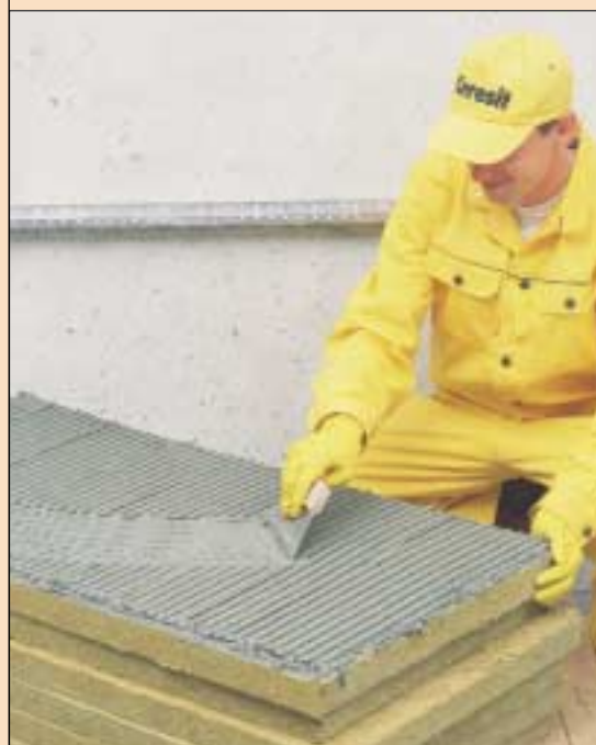
5 Nanoszenie kleju na całą płytę wełny mineralnej (fot. Henkel)
