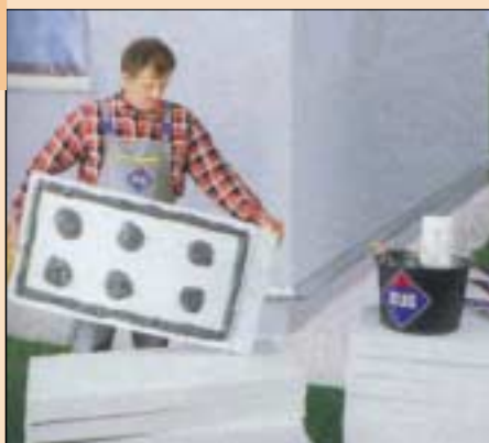
4 Nanoszenie kleju metodą punktowo-pasową (fot. Atlas)
