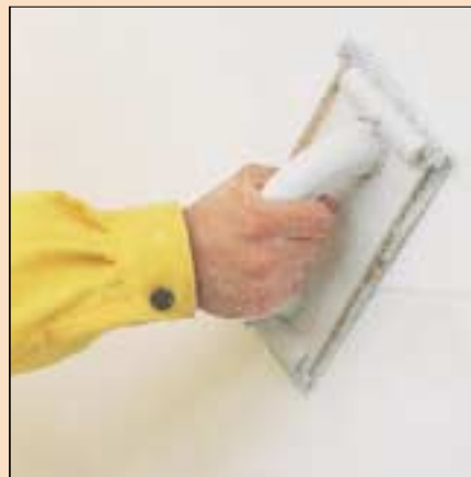
7 Szlifowanie płyt styropianowych (fot. Henkel)
