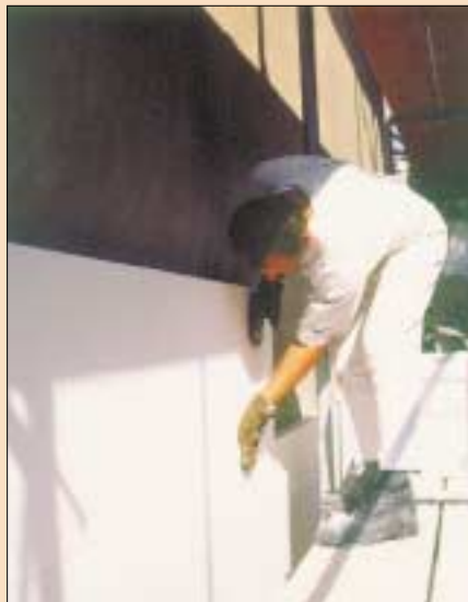
6 Płyty ocieplenia należy montować bez żadnych szpar (fot. Austrotherm)
