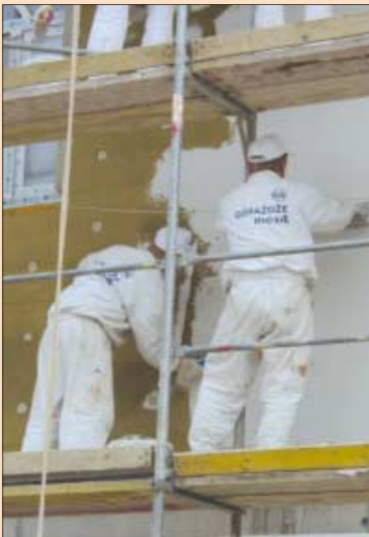
9 Nanoszenie kleju pod siatkę wzmacniającą (fot. Optiroc)
