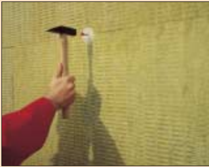
8 Mocowanie płyt ocieplenia kołkami z tworzyw sztucznych (fot. Rockwool)
