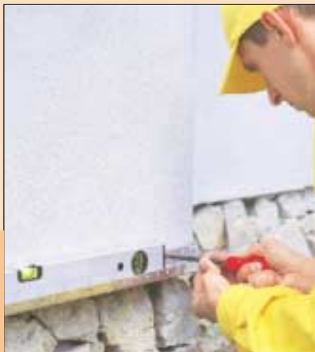
3 Montowanie listew startowych (fot. Henkel)
