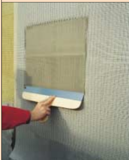
10 Zatapianie siatki w warstwie kleju; widoczny zakład (fot. Rockwool)
