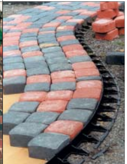
5 Jedno z rozwiązań służących do zabezpieczenia nawierzchni z drobnych elementów przed rozsuwaniem (fot. Ekobord)
