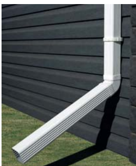
6 Formowanie rynien i rur spustowych na placu budowy eliminuje łączenia elementów na długości (fot. Royal Hurt) ▼
