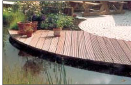
5 Nawierzchnię tego tarasu wykonano z ryflowanego drewna egzotycznego (fot. DLH Drewno)
