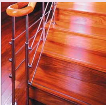
1 Do zabezpieczania drewna wewnątrz domu dobrze jest używać preparatów wodorocieńczalnych (fot. Marko)
