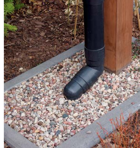
▲ Rynny spustowe znajdują się w częściach narożnych budynku. Każda z nich jest połączona tworzywową rurą drenarską z osobną studzienką chłonną (w każdym rogu działki znajduje się jedna). Część wody deszczowej rozsącza jest poprzez drenaż, reszta trafia do wspomnianych studzienek
