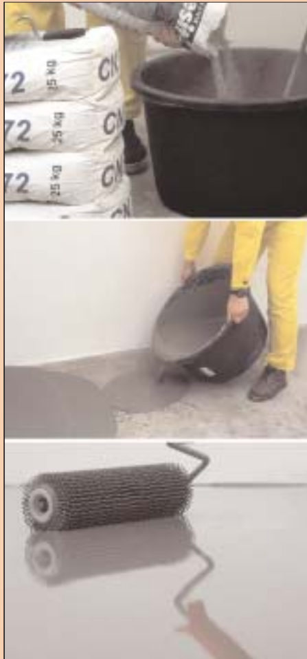
8 Stosowanie wylewki samopoziomującej, od góry: mieszanie suchej zaprawy z wodą, wylewanie na odpowiednio przygotowane podłoże, przegarnięcie wałkiem kolczastym (może być też np. zwykła paca) w celu usunięcia pęcherzyków powietrza (fot. Henkel Bautechnik)
